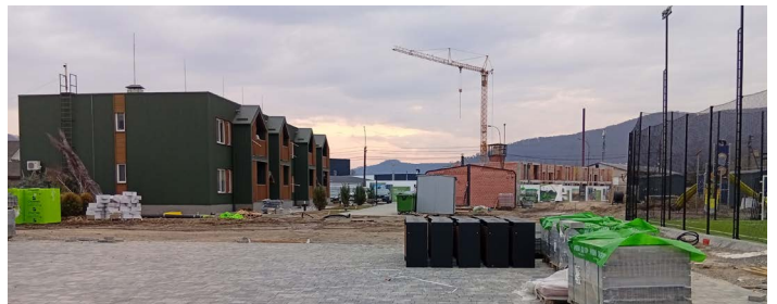
Baustelle Wind Technology Siedlung
