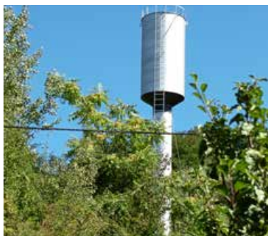
neuer Wasserturm in Kamjanytsia
