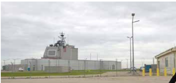
Neue Nato Raketenabwehrstation in Dreveselu in Rumänien. Geplant gegen Iran, errichtet gegen Russland?
